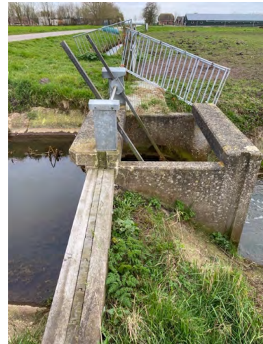
Figuur 1: Inspectie van kunstwerken
